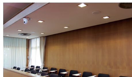
傍聴席の天井の色に合わせて白いカメラとスピーカー2台が設置されている。
