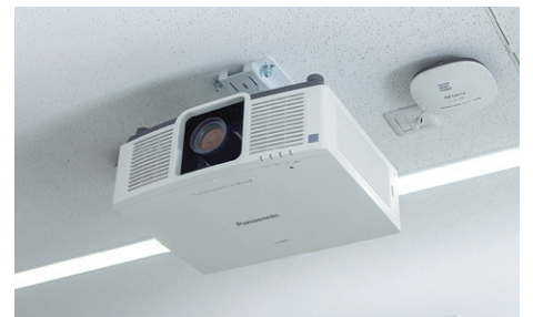
2~3階の講義室には7,000lmの液晶レーザー方式の プロジェクターを設置している。
