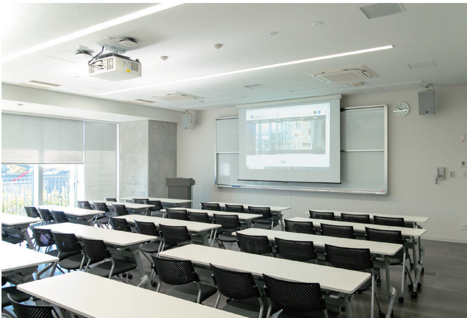
2~3階の講義室は、室内のどこからでも明瞭な音声で授業に集中できるように スクリーン両脇にメインスピーカーを配し、天井にシーリングスピーカーを設置している。
