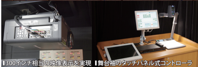
■ハイエンドな設備が導入されたホール
